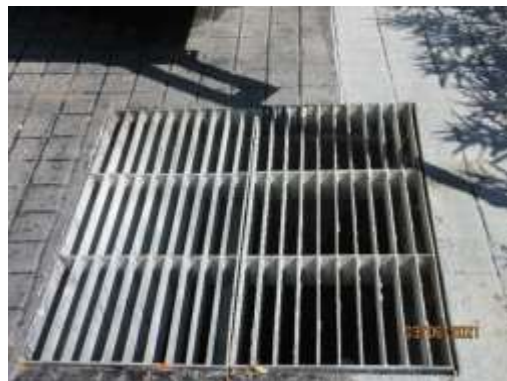
รูปที่ 5 ตะแกรงดักขยะก่อนระบายน้ำออก
