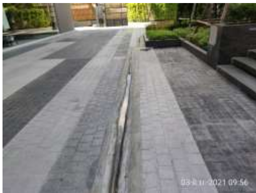
รูปที่ 5 ตะแกรงดักขยะก่อนระบายน้ำออก
